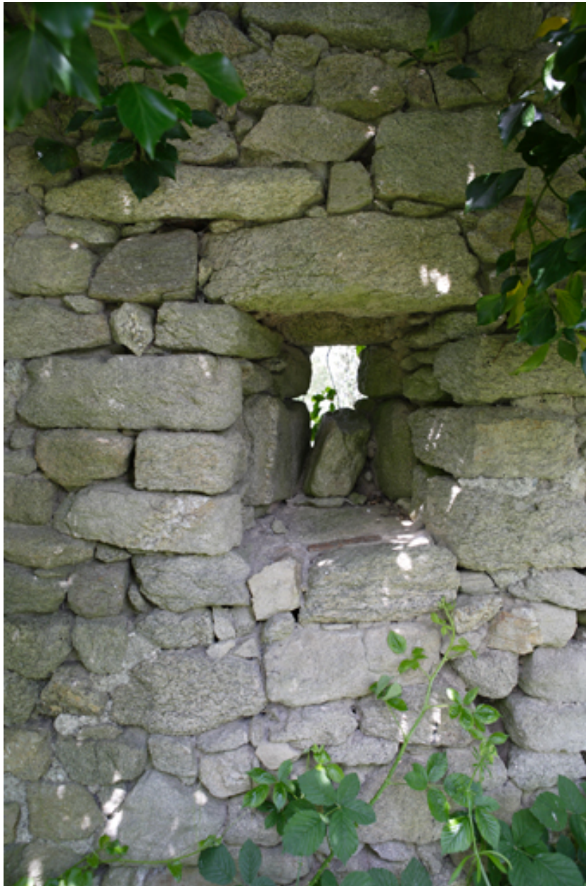
Détail du jour d'éclairage sur le pignon nord de la chapelle (?).
