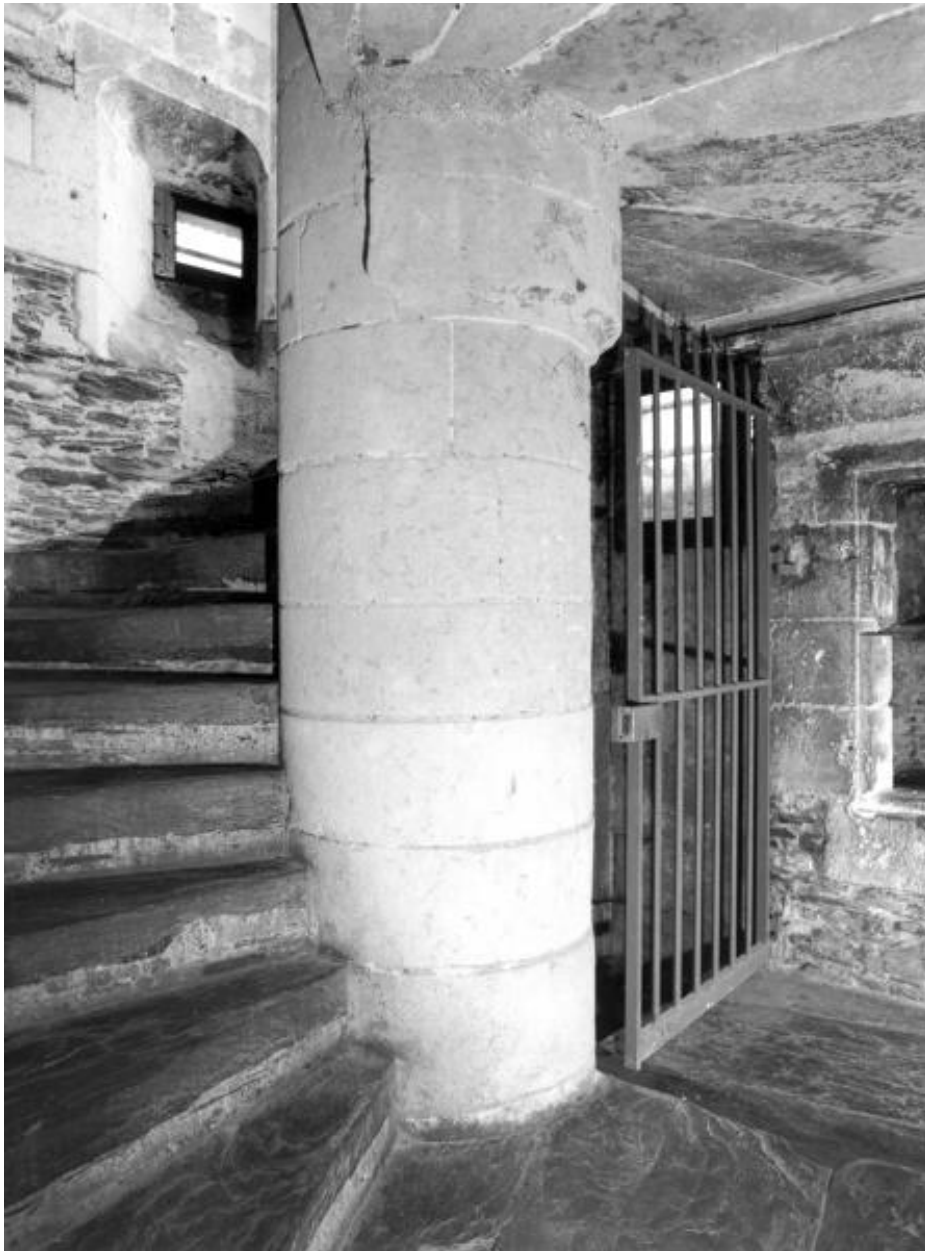
Etage de soubassement : départ de l'escalier.
