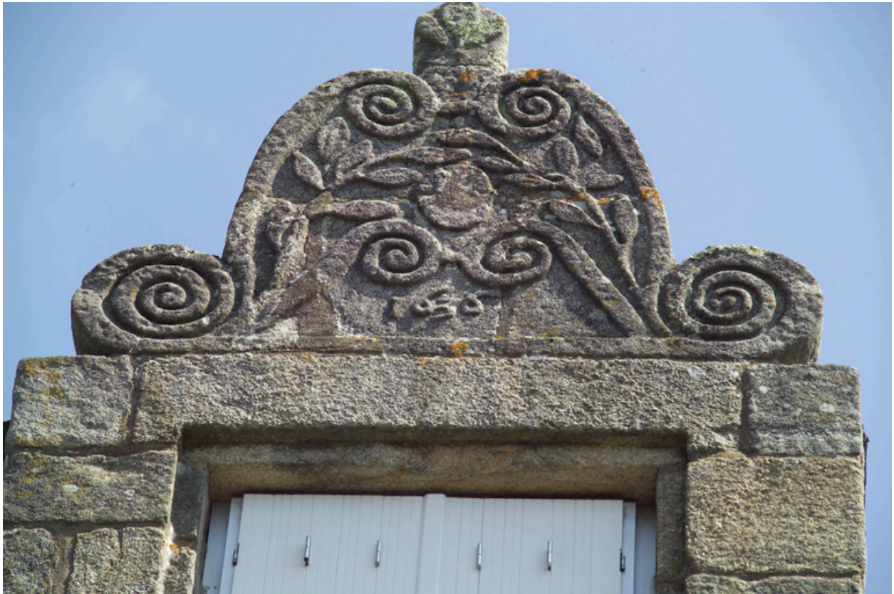
Détail de la lucarne.
