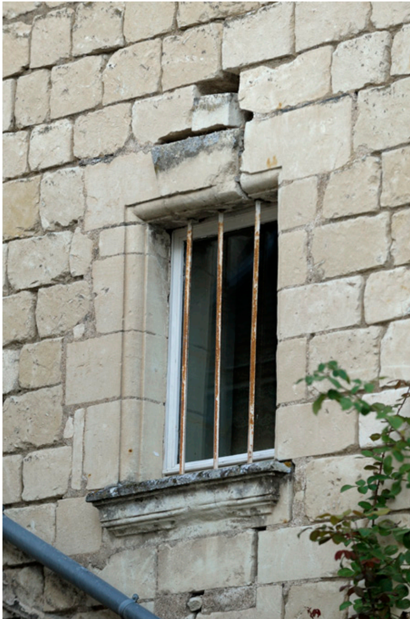
Pignon est. Baie (XVI e siècle), avec reprise de maçonnerie.
