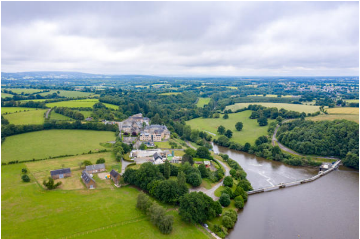
Le barrage de Saint-Fraimbault-de-Prières.
