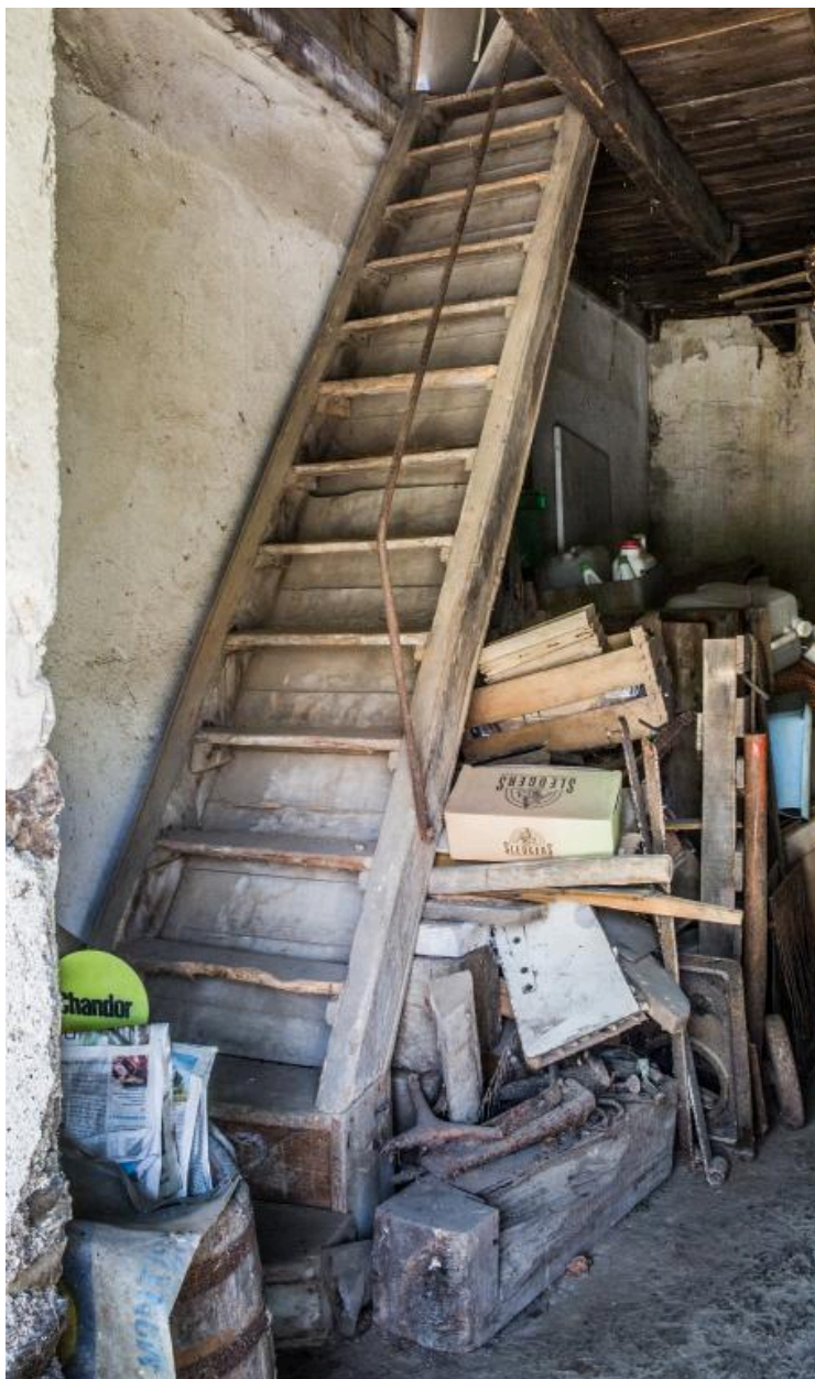
Escalier en charpente droit avec contremarche permettant l'accès au comble d'une habitation. La Brégeoennière, La Boissière-du-Doré. Cadastre 2018, B 01-703.
