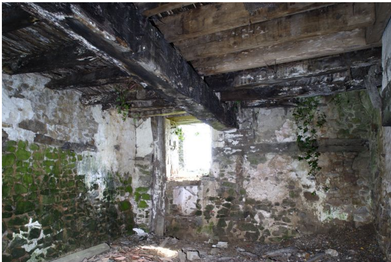
Rez-de-chaussée, pièce sud : le mur est.
