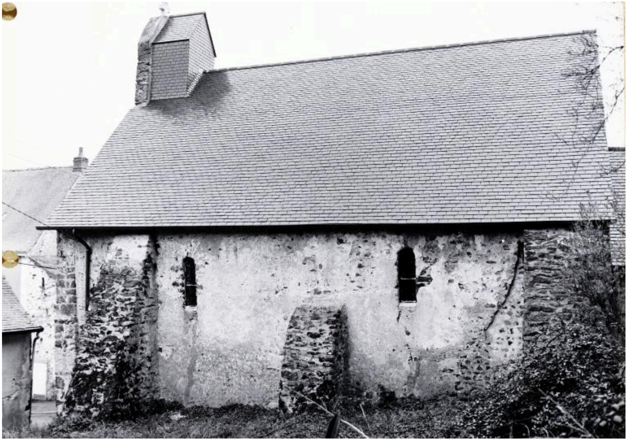
Nef, élévation latérale sud.
