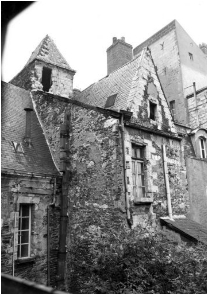
2e corps sur cour, pignon sud et partie haute du corps d'escalier.
