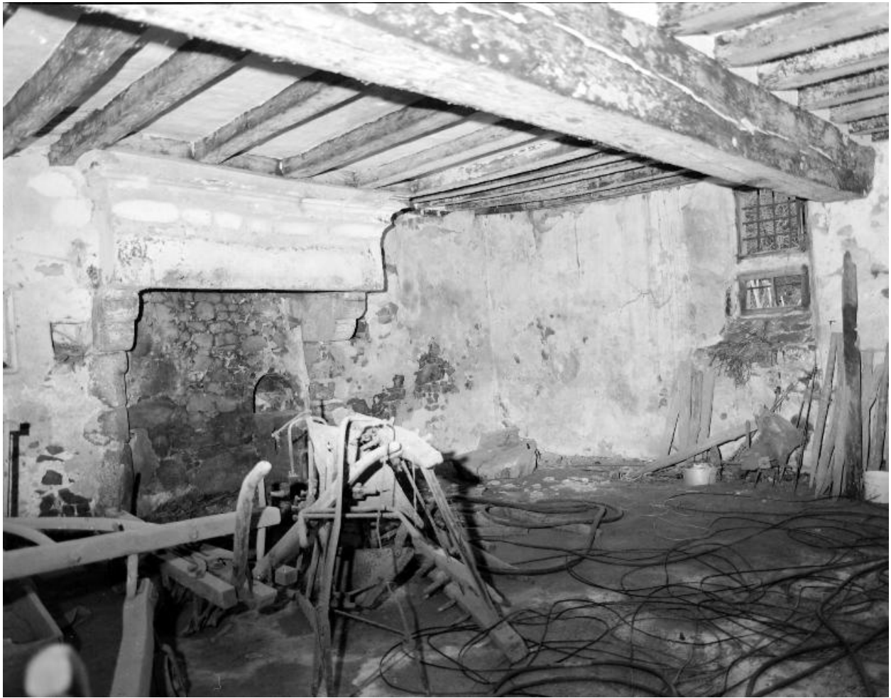
La principale pièce du rez-de-chaussée vue du sud-ouest.
