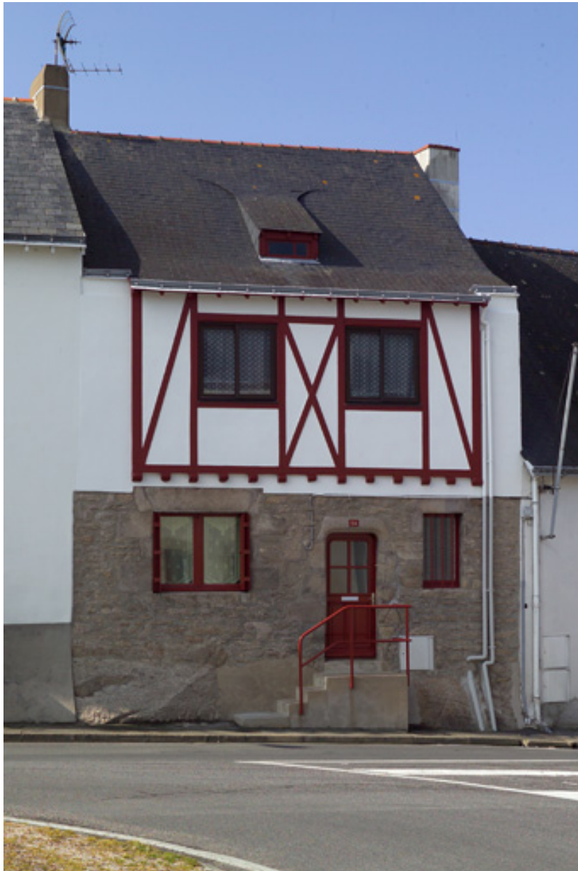
Vue de la façade nord.
