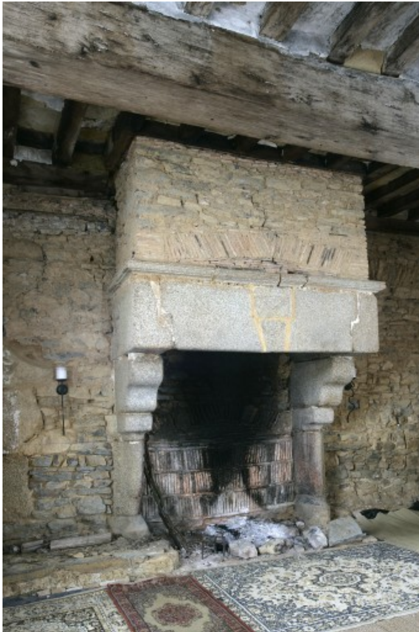
Le logis manorial, salle : la cheminée.
