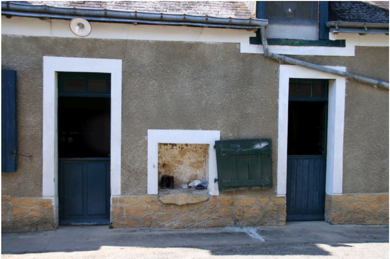
Maison 2, façade antérieure sur rue : niche extérieure.
