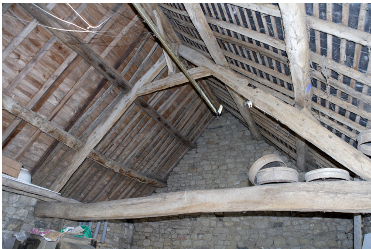
Dépendances. Détail de la charpente.
