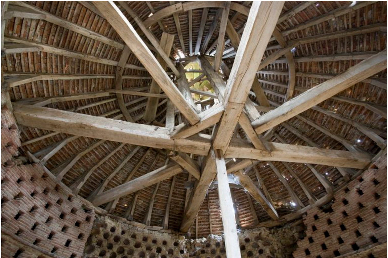
Charpente du colombier
