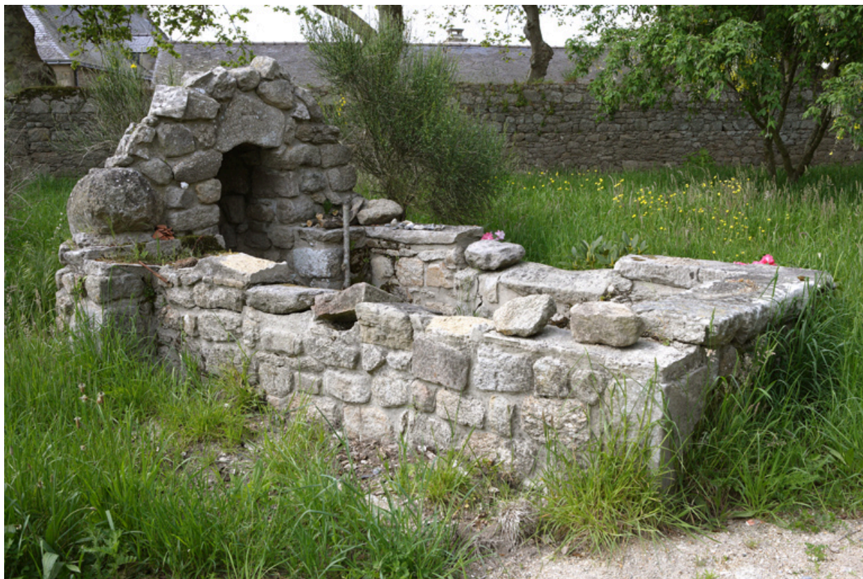
Cour. Vue de la fontaine.
