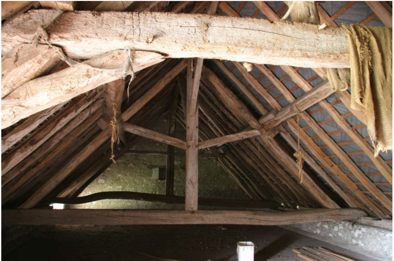
La Basse-Morinière, vieille maison : charpente à pannes sur comble à surcroît.
