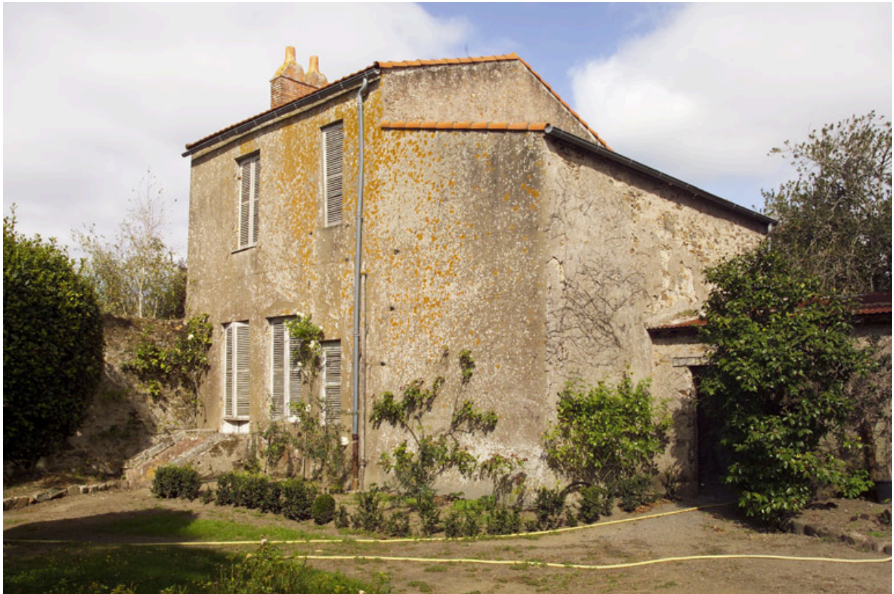
Maison utilisée comme dépendance vue depuis le jardin au sud.
