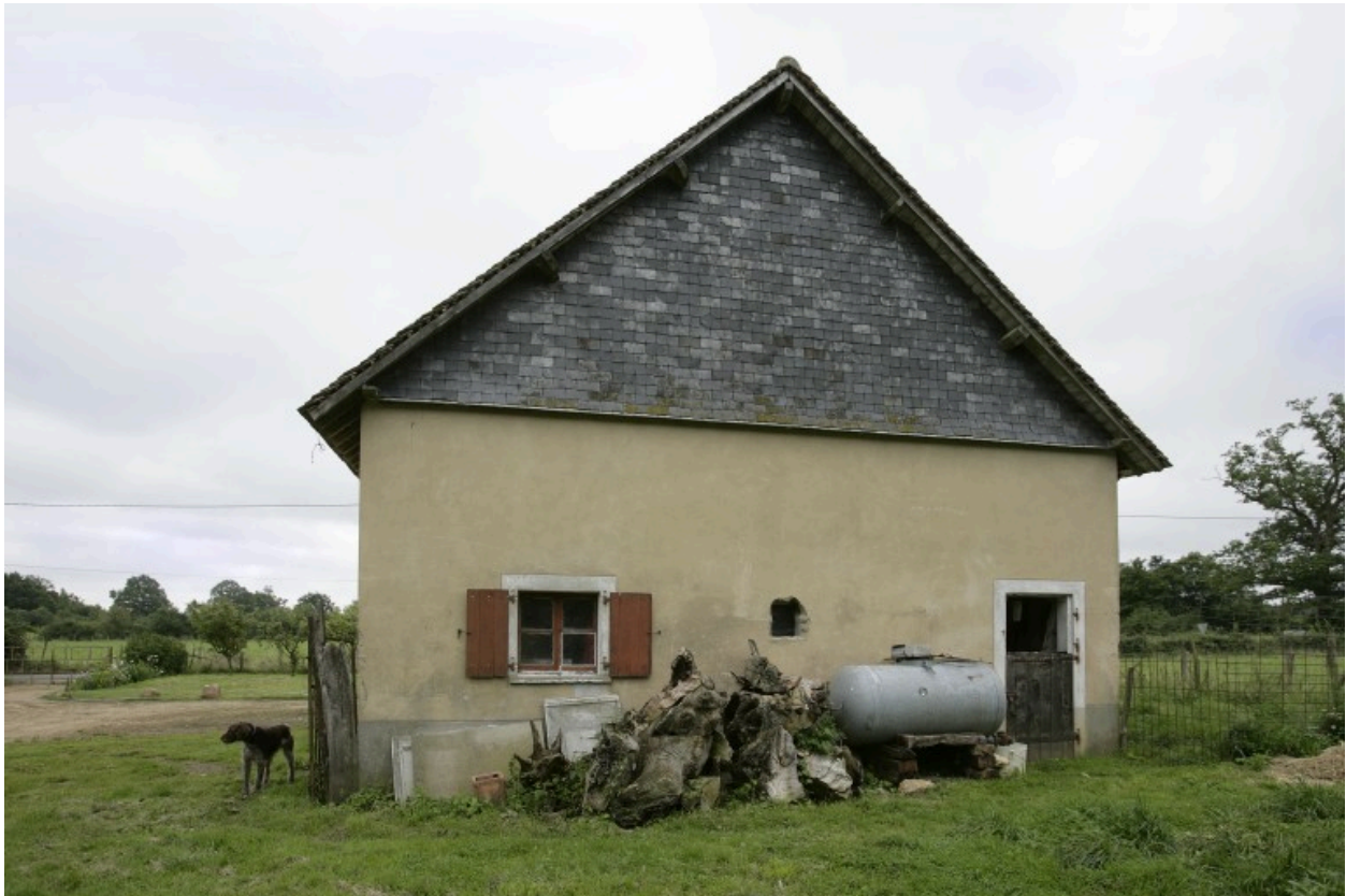
Grange-étable : mur-pignon ouest avec fenêtre du logement.
