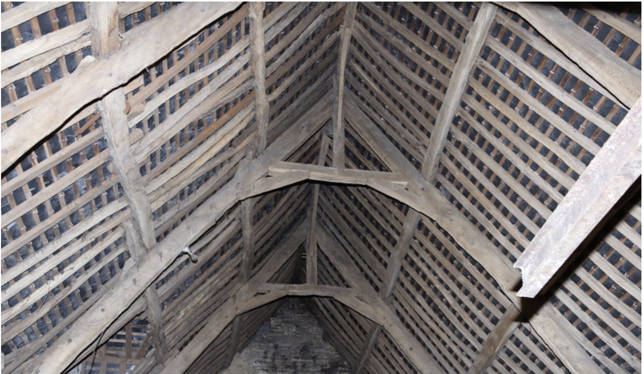
Bâtiment ouest. Détail de la charpente depuis le nord.
