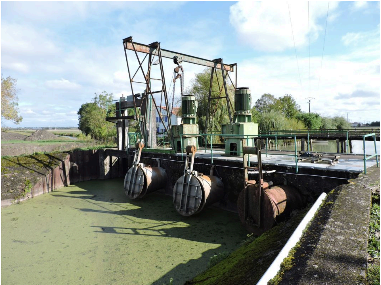
Le barrage et ses trois clapets vu depuis l'aval, au sud-ouest.
