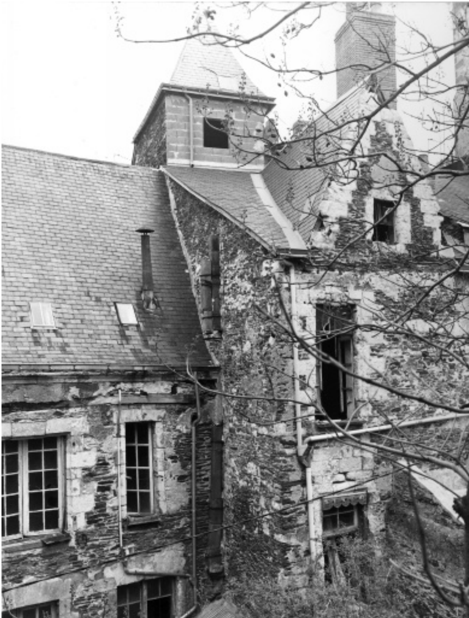
A gauche : maison n° 52-54, façade postérieure. A droite : maison n° 56, face arrière du logis postérieur et partie haute de la tour d'escalier.
