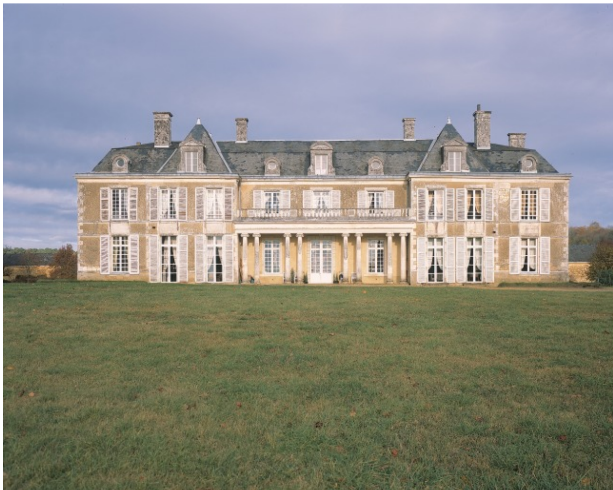
Façade postérieure sur le parc.
