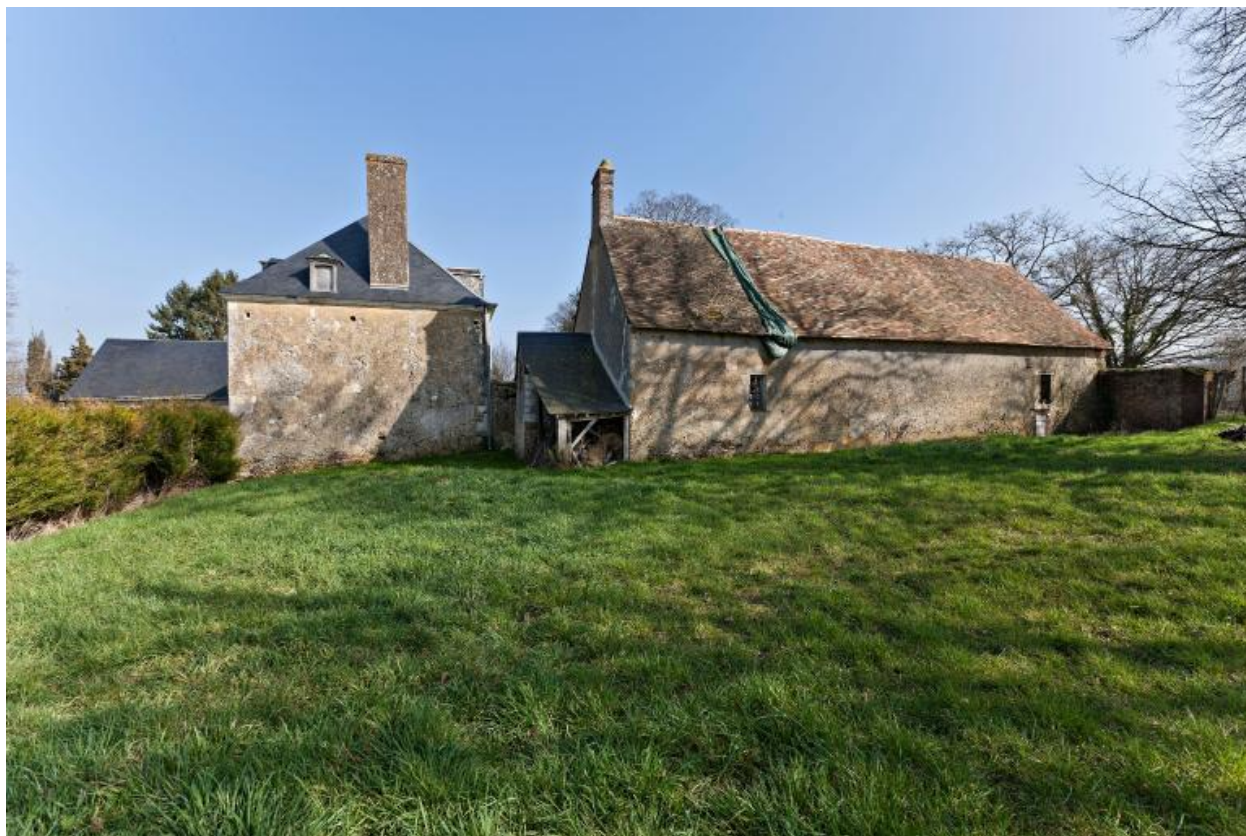
Maison et dépendances, depuis l'ouest.
