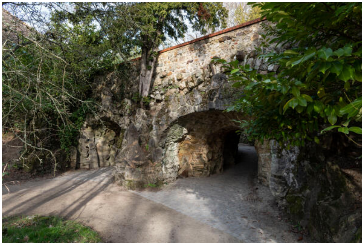
Vue du tunnel rocaille liant la partie "jardin à la française" à la partie "jardin à l'anglaise".
