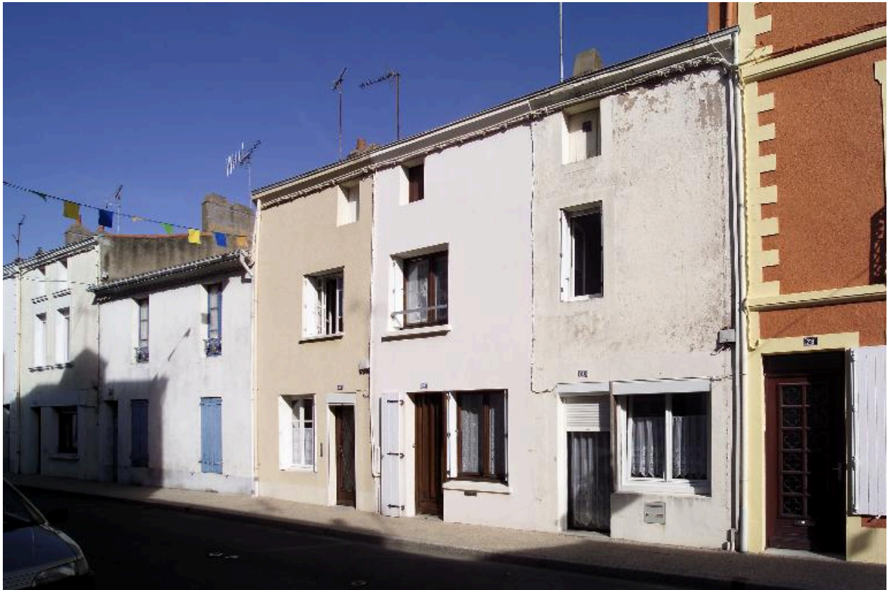
Vue de la façade des maisons n° 78 à 82 rue du Général-De-Gaulle.
