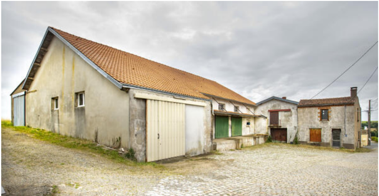
Façade et quai du magasin ; à gauche, accès au local de lavage des fûts.
