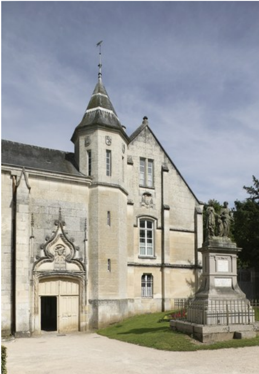
Bâtiment sud : vue prise de l'ouest, montrant le mur pignon et la tour d'escalier, reconstruits par Lisch. A gauche, la porte d'accès à la galerie ouest du cloître.
