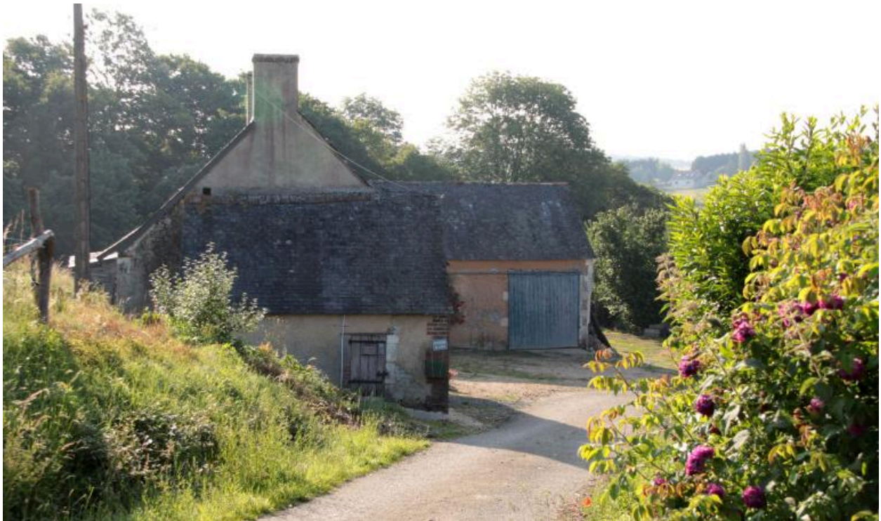
Vue prise depuis l'ouest. Toits à porcs accolés à l'ensemble d'habitation.
