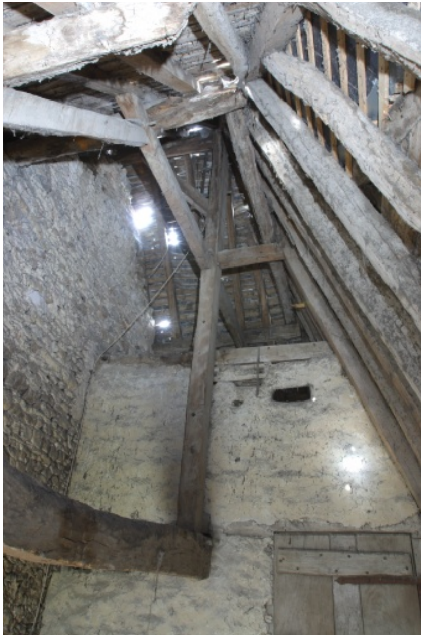
Comble de la cage d'escalier : la charpente.
