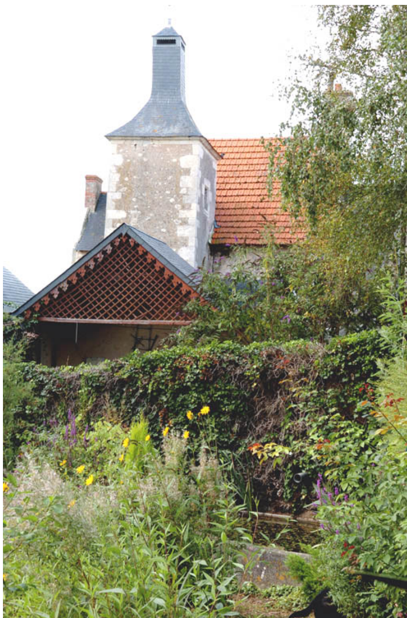
Vue de volume de la tourelle d'escalier.
