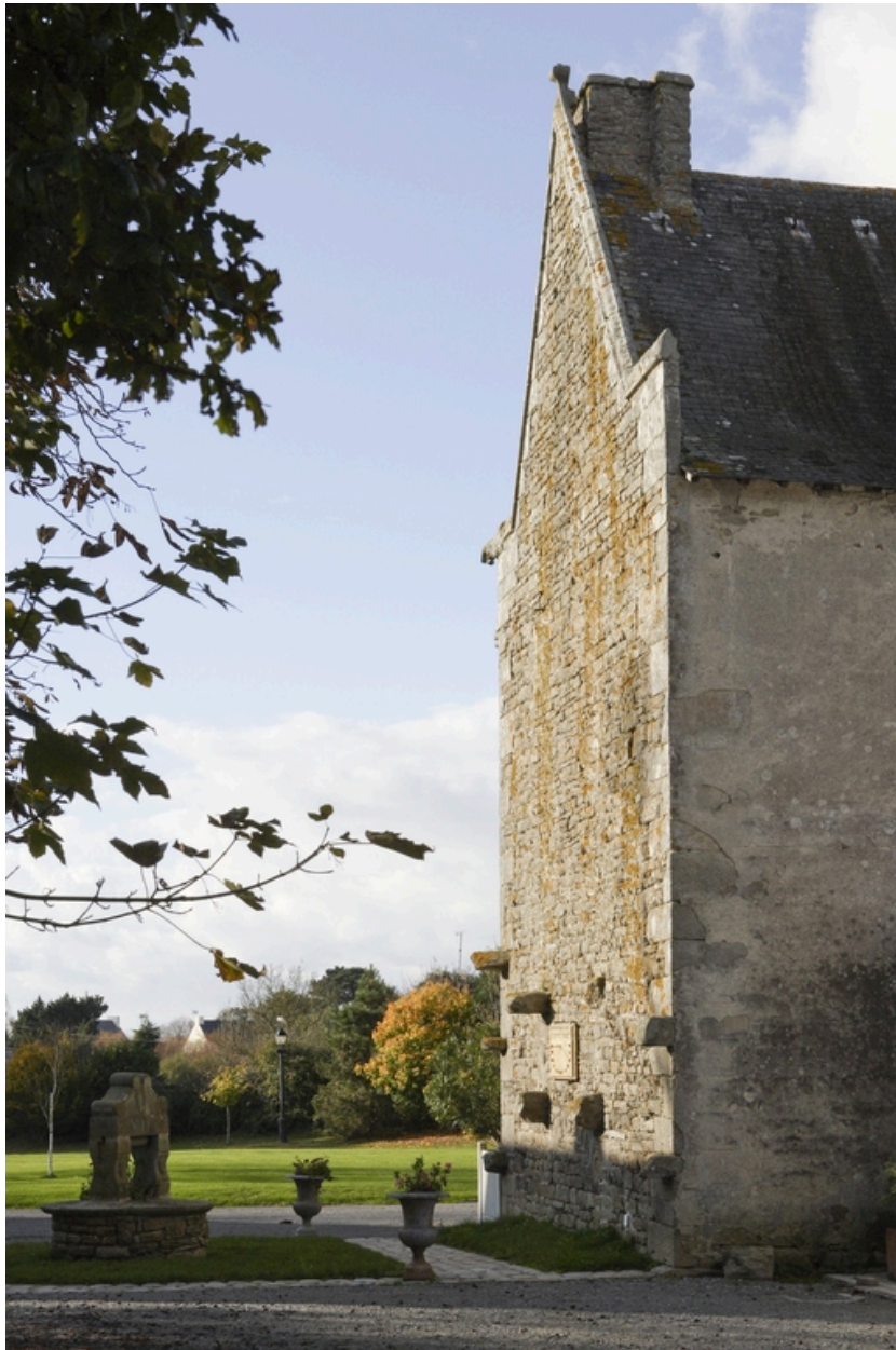
Logis. Aile est. Vue du pignon sud.
