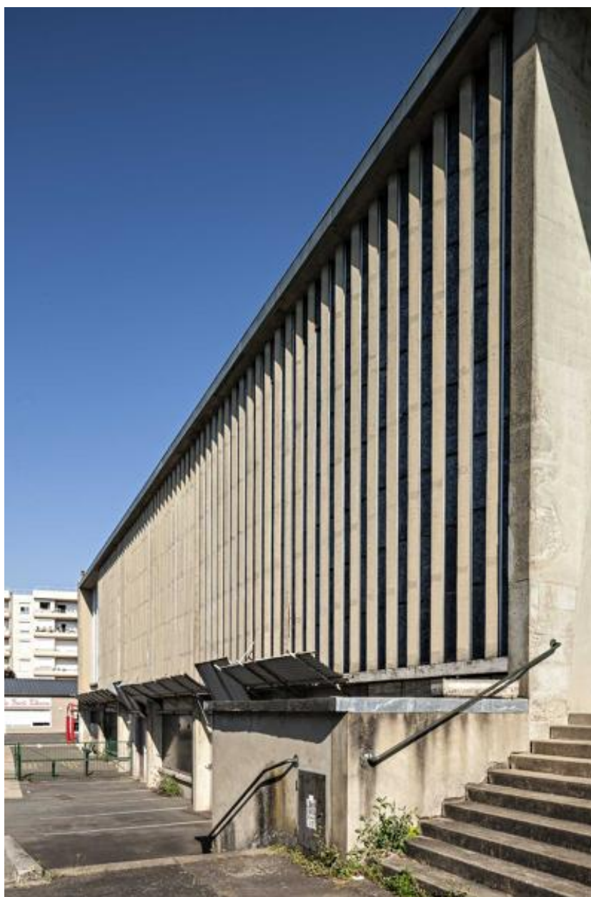
Vue de la façade latérale depuis l'extérieur.
