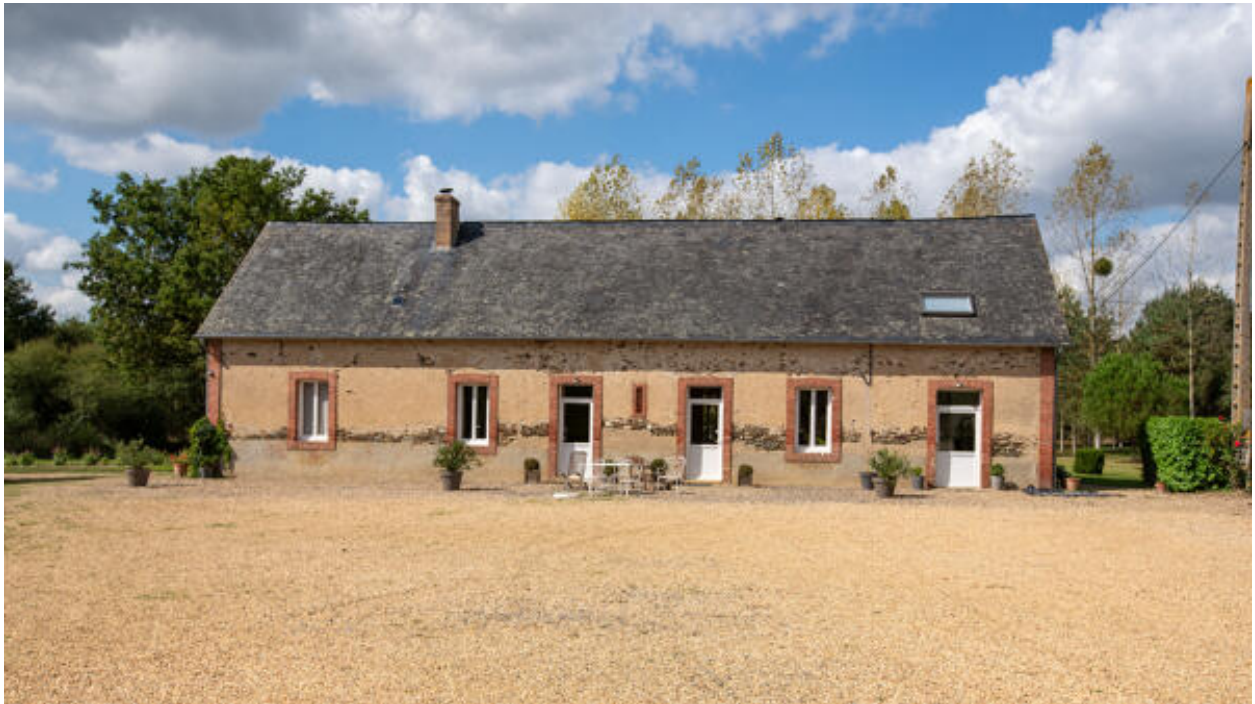
Le corps ouest, logement.
