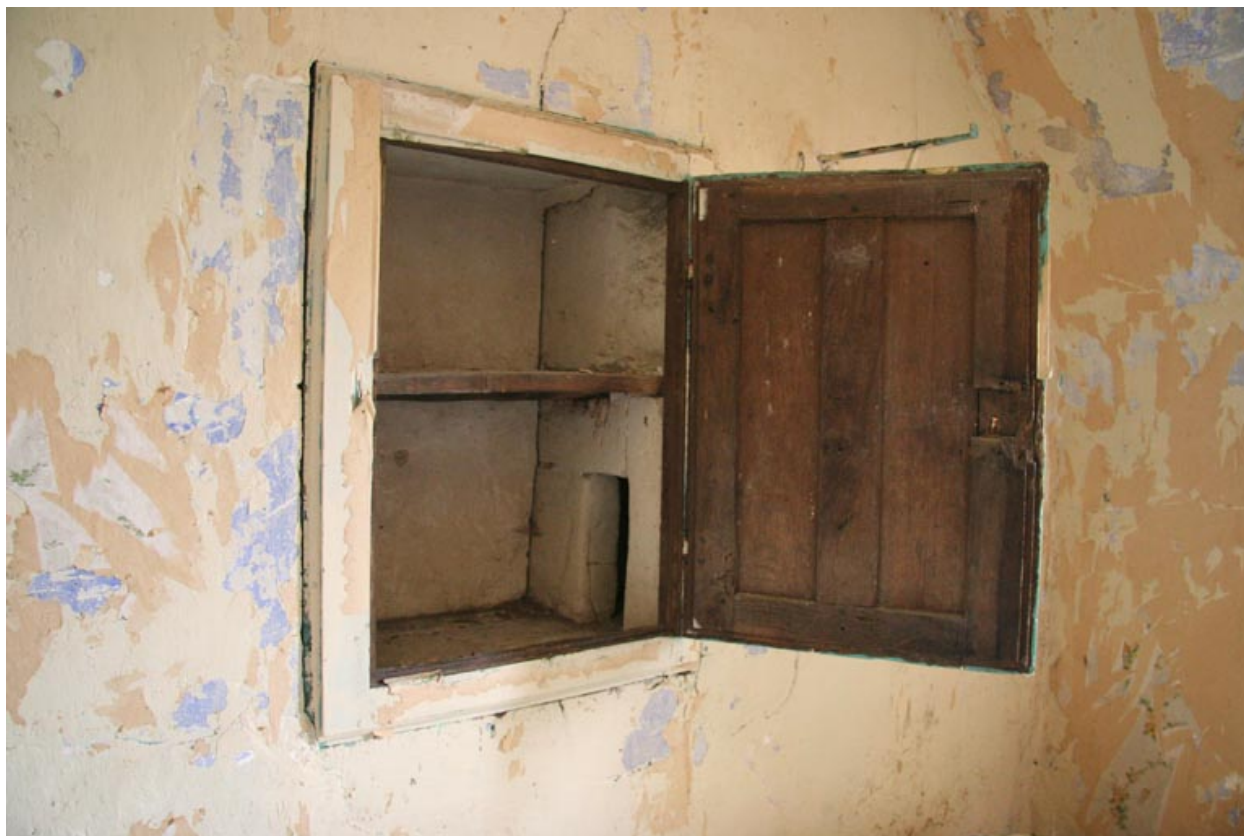
Premier étage de la tour : placard.
