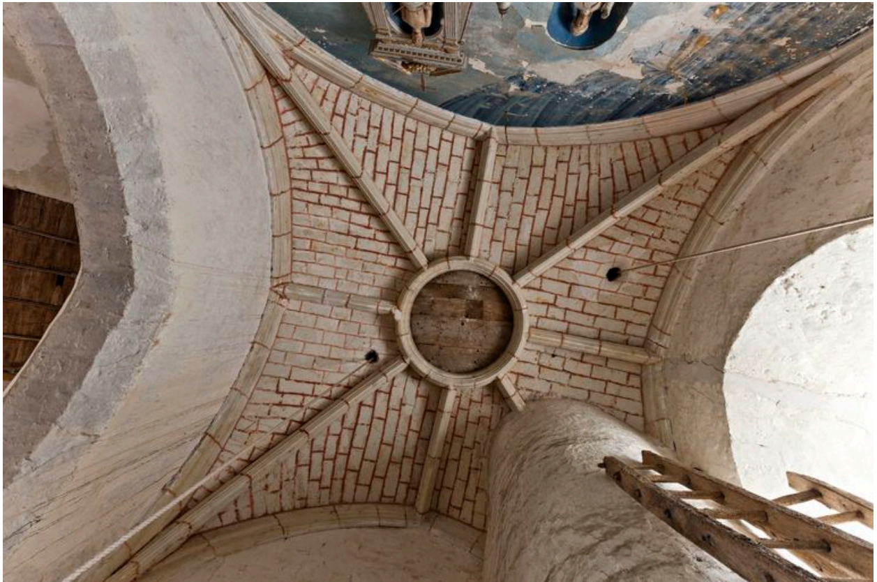
Voûte de la chapelle et tour d'escalier réalisée en 1623-1624 par Jehan Viet.
