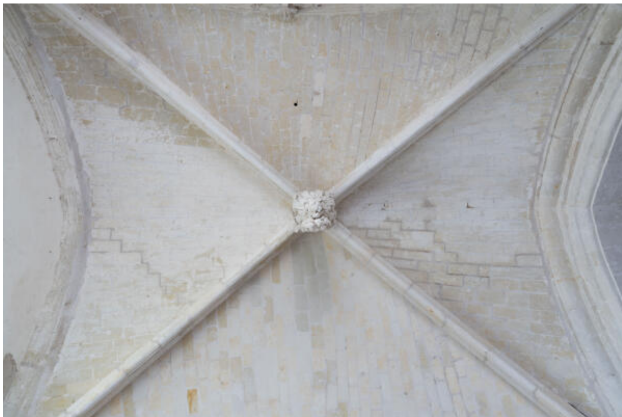
Chapelle latérale : voûte de la travée est.
