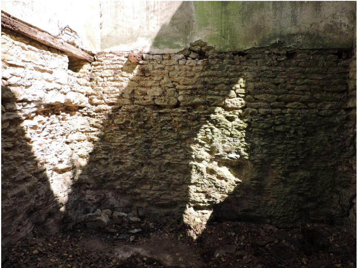
Vue intérieure de l'étage de soubassement, en partie creusé dans le rocher.
