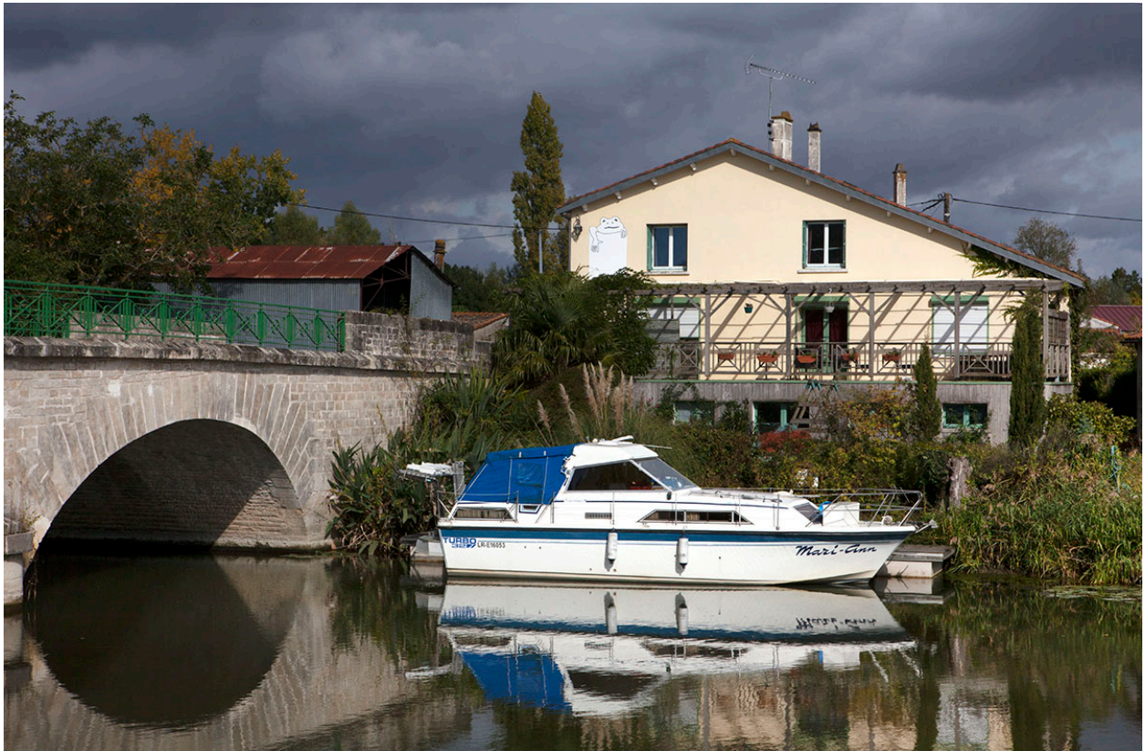
L'ancienne auberge vue depuis le sud.
