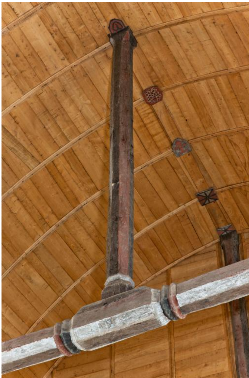
Sacristie. Détail du poinçon du 2e entrail à partir du mur jouxtant le chœur.
