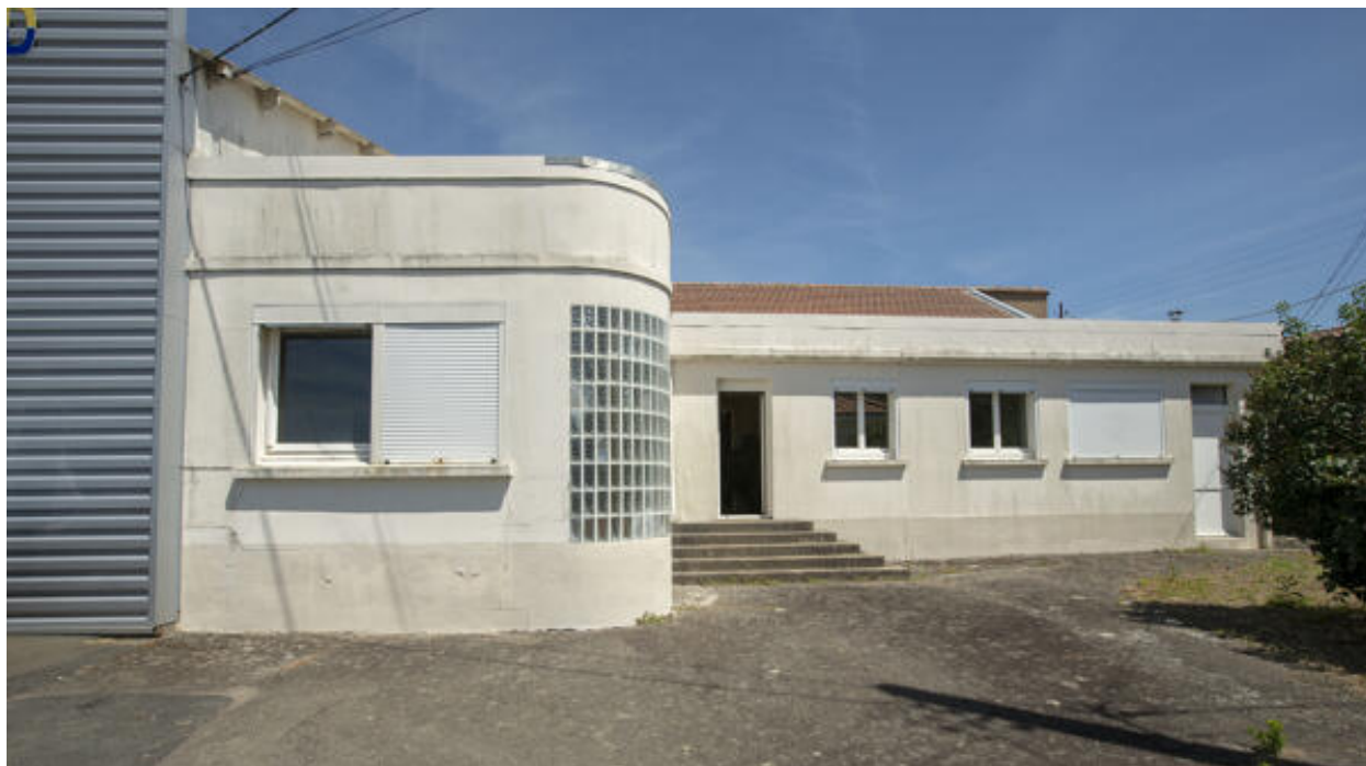
Vue générale du bâtiment de négoce sud.
