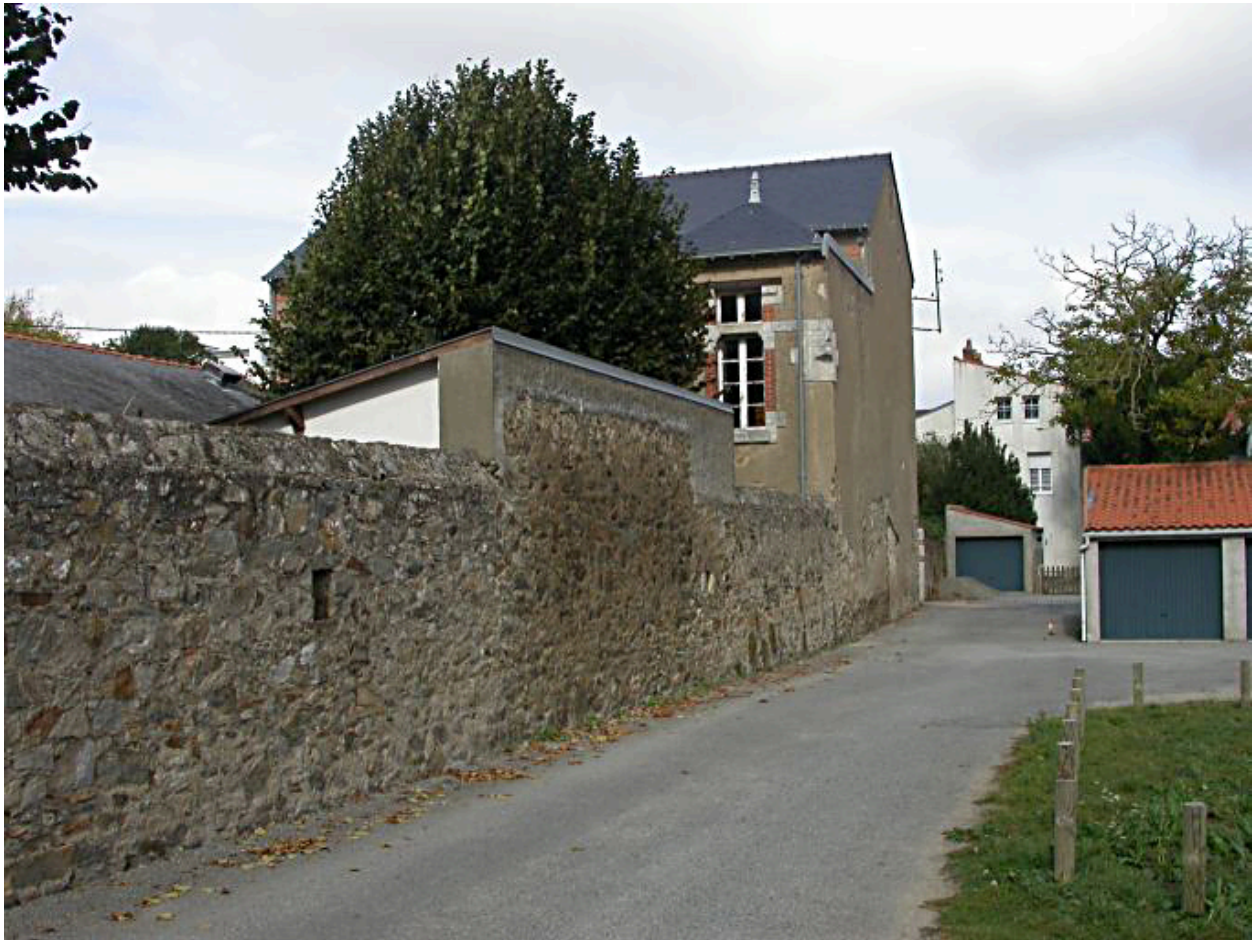
Vue prise depuis le boulevard à l'est, au centre, l'école primaire.
