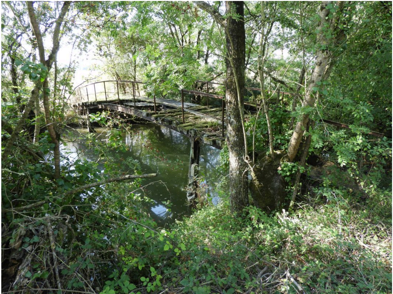
La passerelle vue depuis le nord-est, franchissant le Contrebot.
