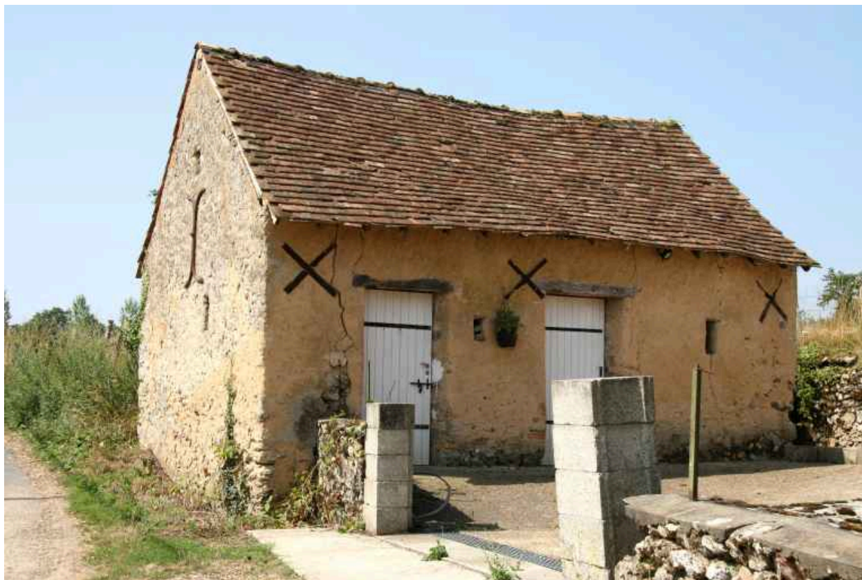
Parcelle 139 : écuries d'une maison n°2 disparue.
