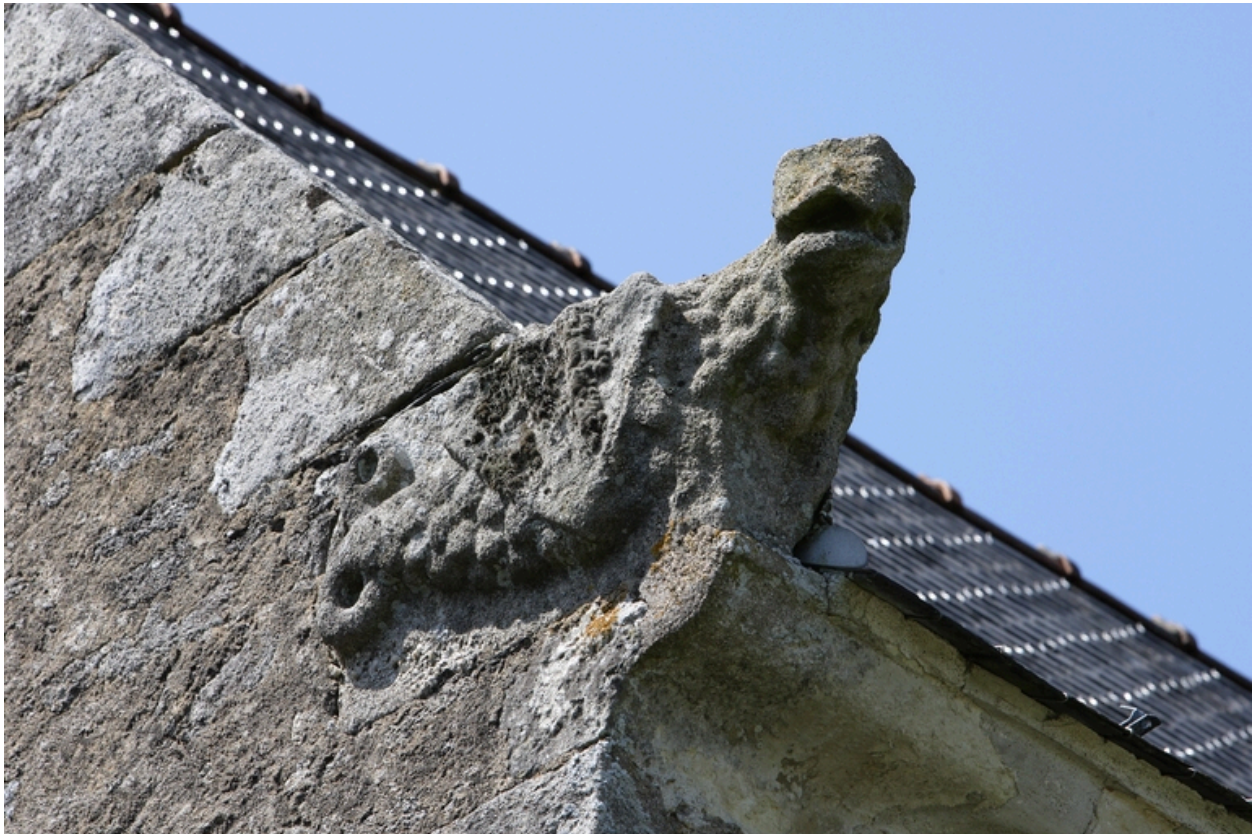
Façade est. Détail de l'acrotère dans l'angle sud-est du pavillon.
