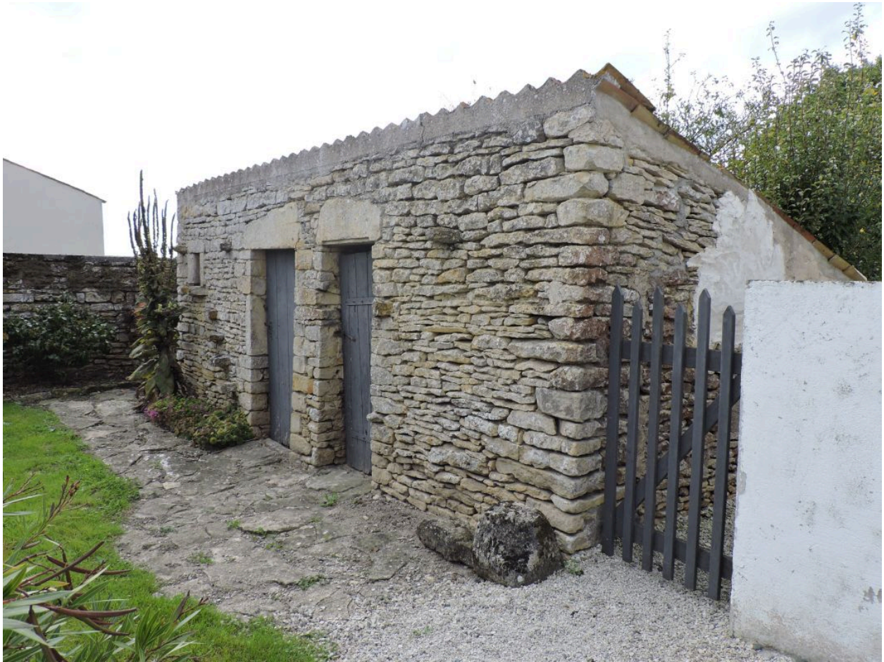
Anciens toits au sud du logis.
