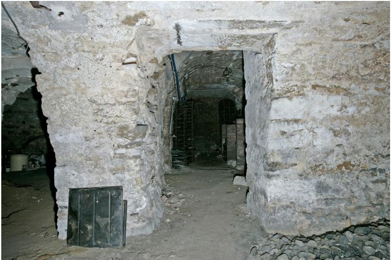
Le pavillon, sous-sol, 2007.
