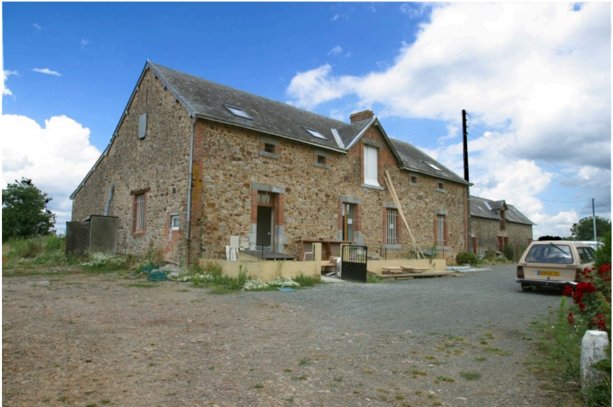
Le logis vu du sud-ouest.
