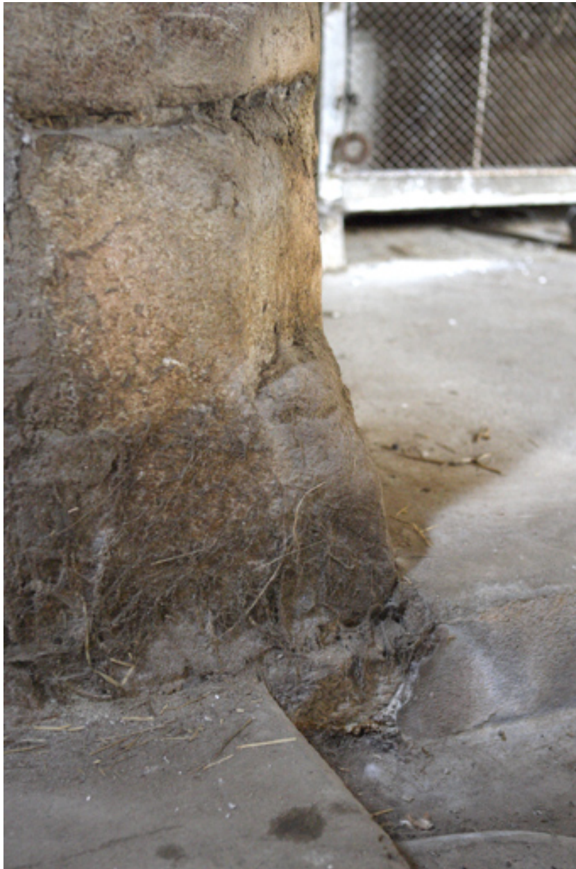
Logis. Cheminée. Chanfrein à la base du tableau de gauche, détail.
