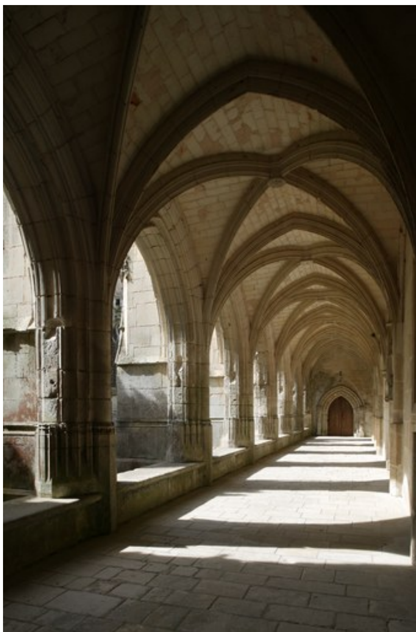
Aile est du cloître : vue intérieure de la galerie.
